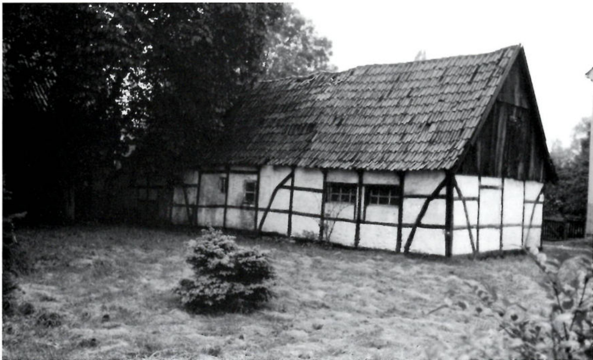
Abbildung 7: Das erste Wohnhaus Grieskamp's Hof und spätere Stallgebäude
